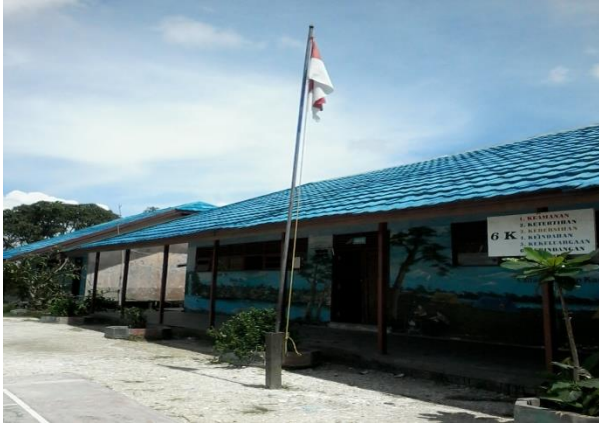
Bangunan MIN 11 Banja
