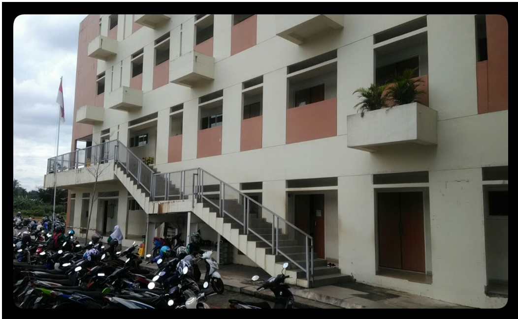
Bangunan ruang kelas dan kantor di SMAIT Ukhuwah Banjarmasin
