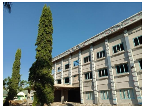
Gambar 2. 6 Pembangunan Gedung Baru untuk JCH
