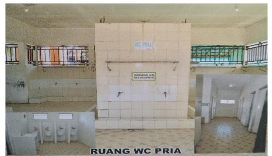
RUANG WC PRIA
