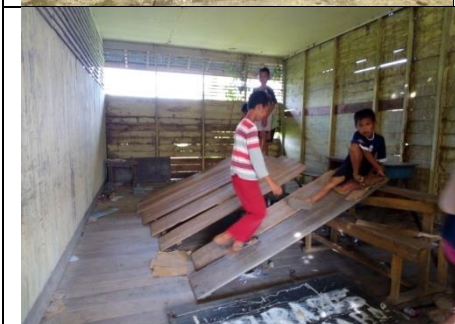
CDF.024 Ruangan Madrasah / Taman Pendidikan Al-Qur'an, yang tidak terpakai dan dijadikan tempat bermain
