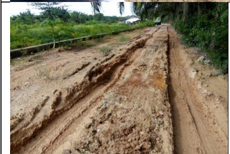
CDF.015 Jalan menuju pemukiman warga
