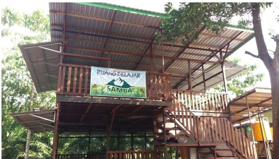
Gambar 4.1 ruang kelas di Sekolah Alam Batulicin Kabupaten Tanah Bumbu
