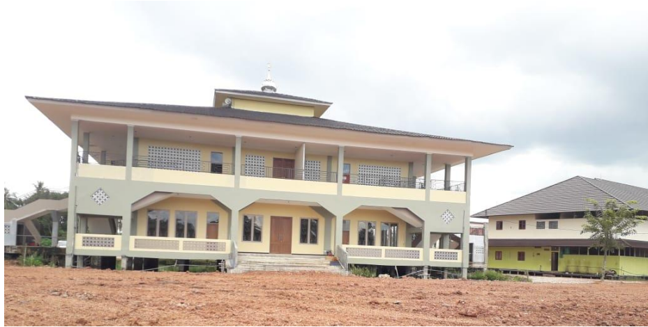
Gambar Bagian Depan Masjid Al Firdaus yang dibagian atas digunakan sebagai ruang kelas
