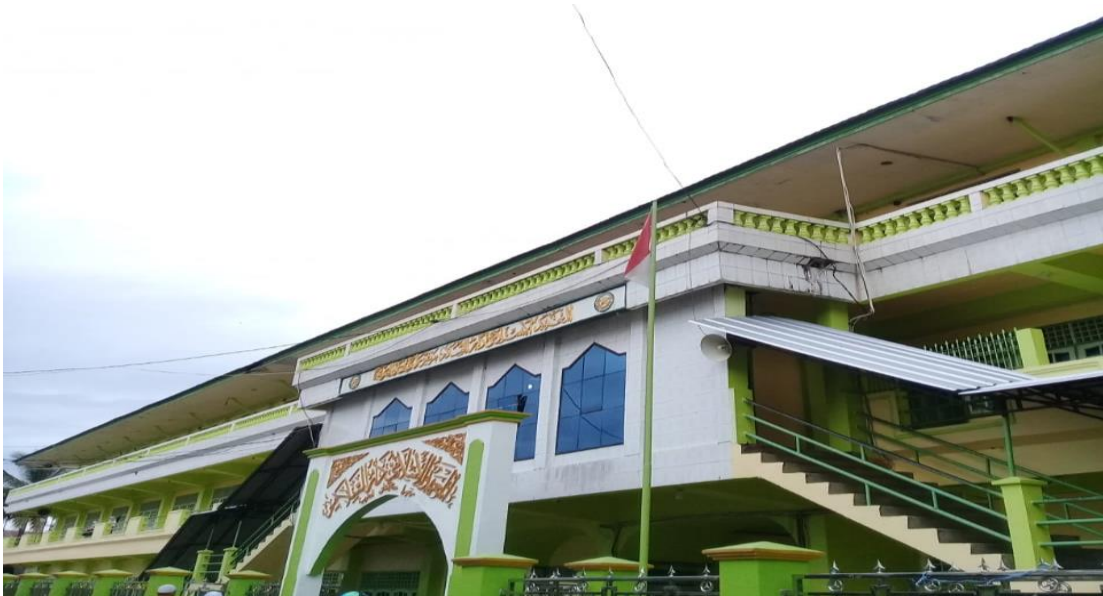
Gambar II : Bangunan Kelas Pondok Pesantren Darussalam
