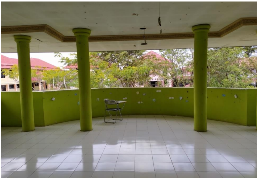
Balkon lantai II Asrama II
