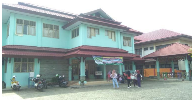
Bangunan SLB Negeri 2 Banjarmasin
