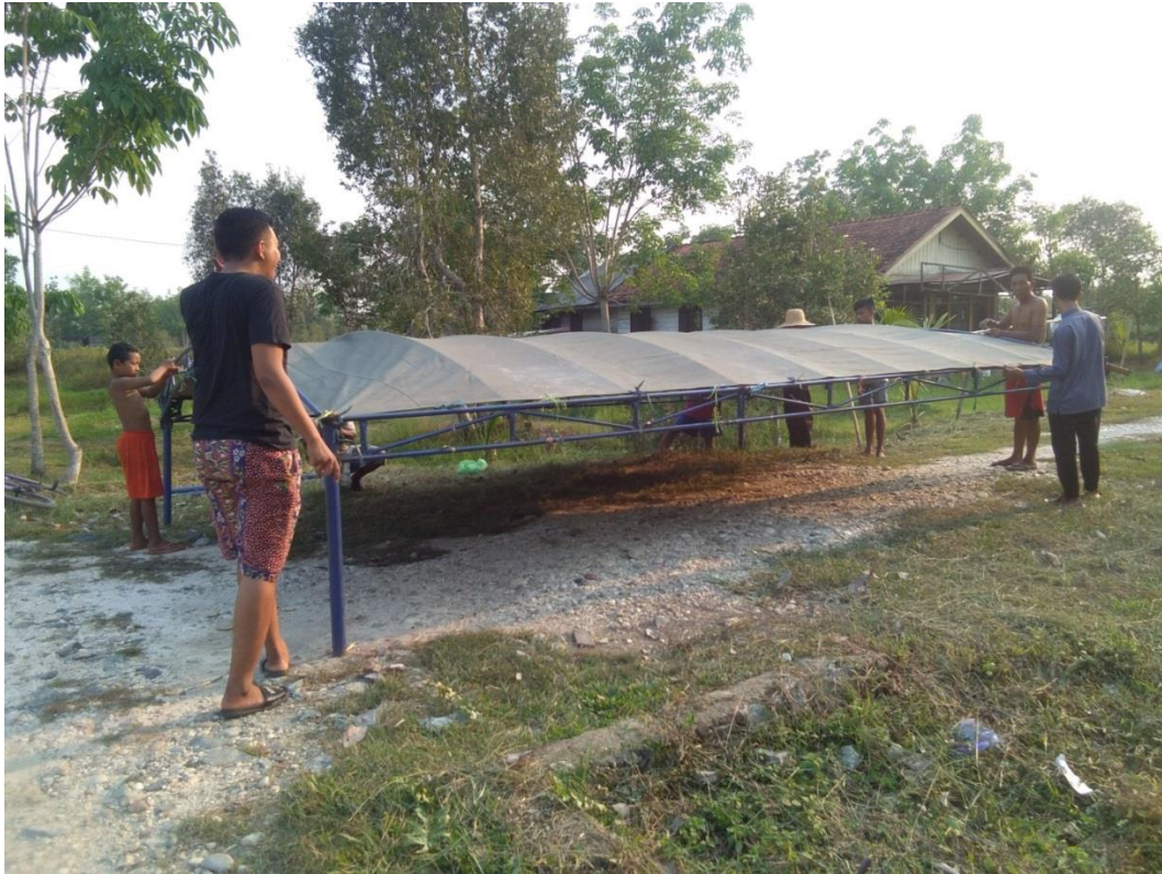
Saat pemasangan tenda yang dilakukan oleh masyarakat di perempatan jalan Desa
