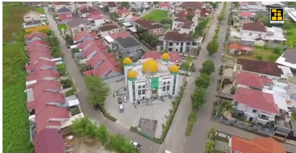
Gambar 4.2 Masjid Bunyamin Residence tampak dari atas
