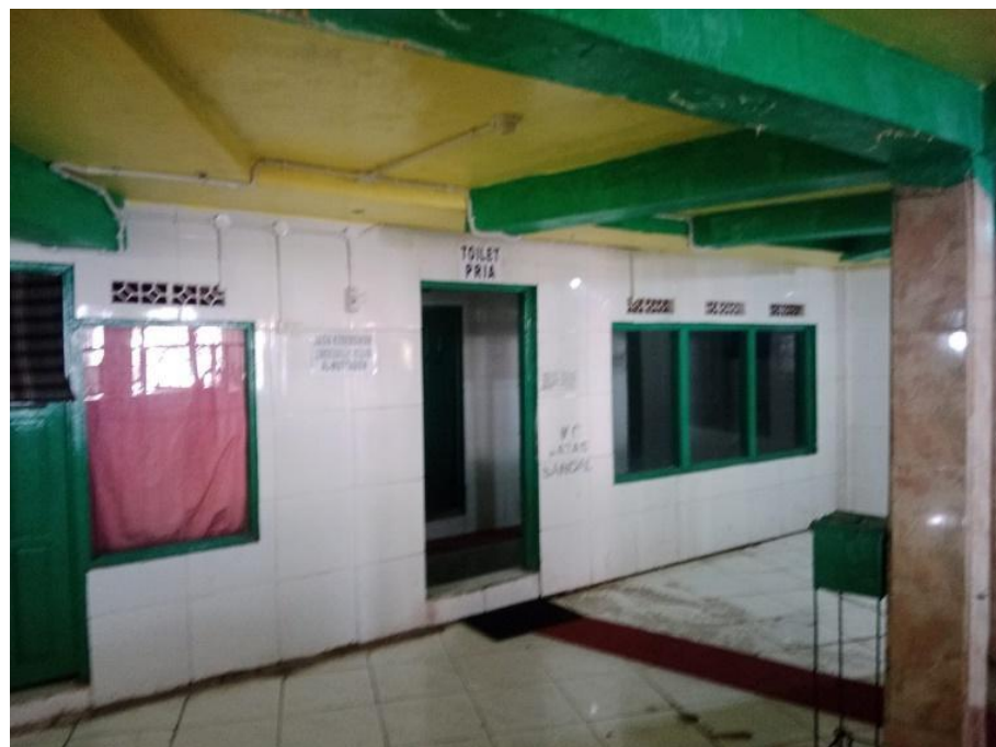
Gambar 4.7 Toilet/WC Laki-laki bagian belakang Masjid dekat Tk Al-Muttaqien.
