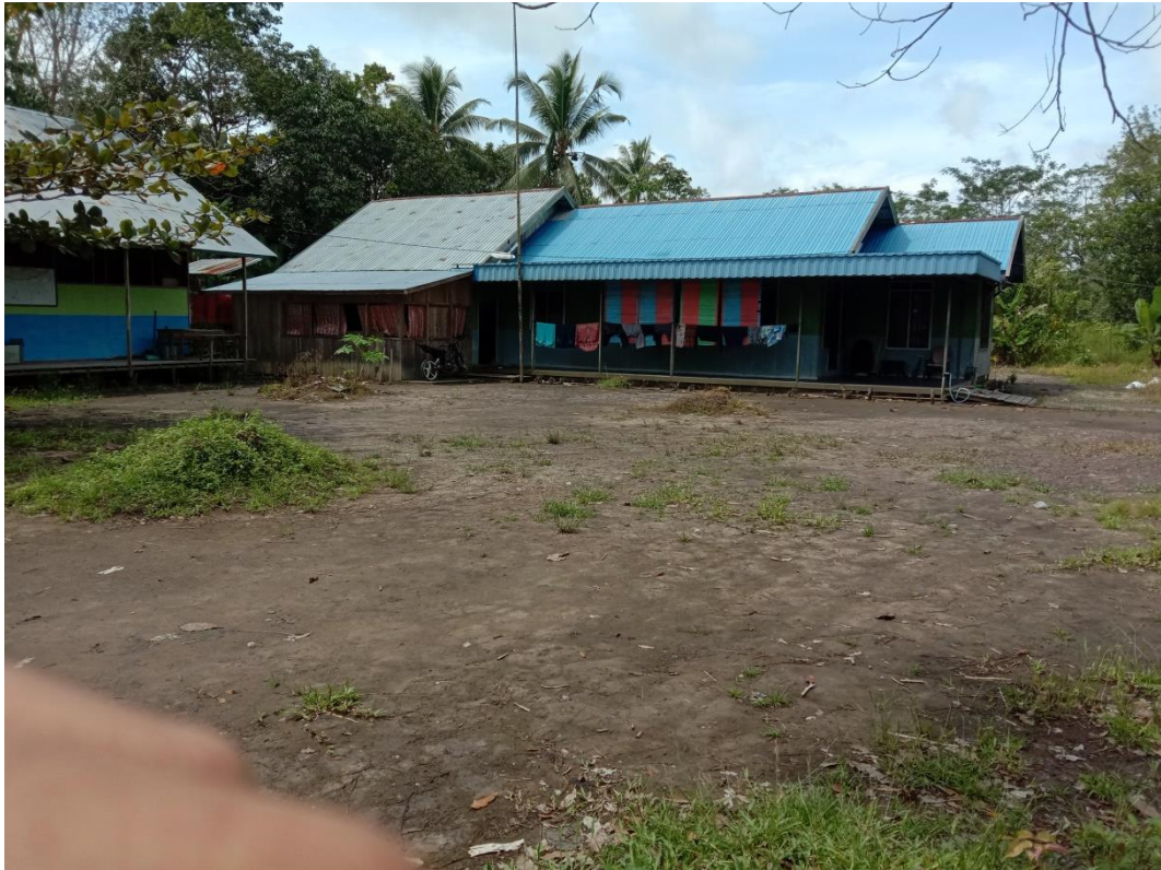
Lapangan Tampak Serong kanan
