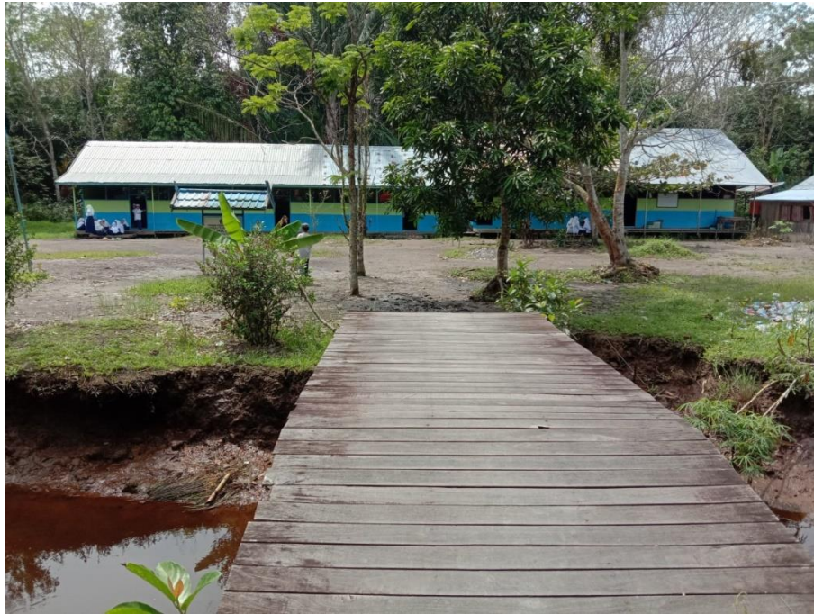
Tampak dari jalan sebelum melewati jembatan
