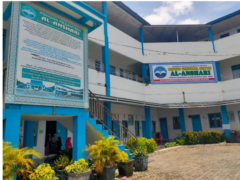
Gambar 4.1 Gedung 3 lantai Pondok Pesantren Tahfiz Al-Qur'an Al-Anshari (Tempat ruangan kamar/ asrama dan ruangan kelas santriwati)
