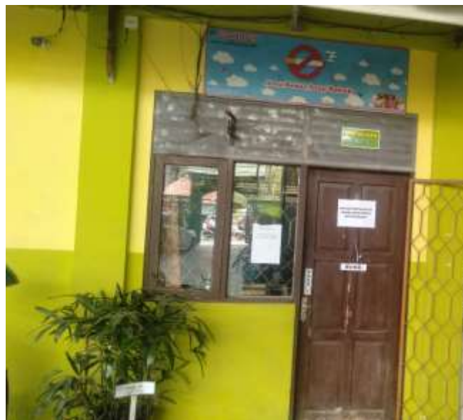
Bangunan Tata Usaha MAN 1 Banjarmasin
