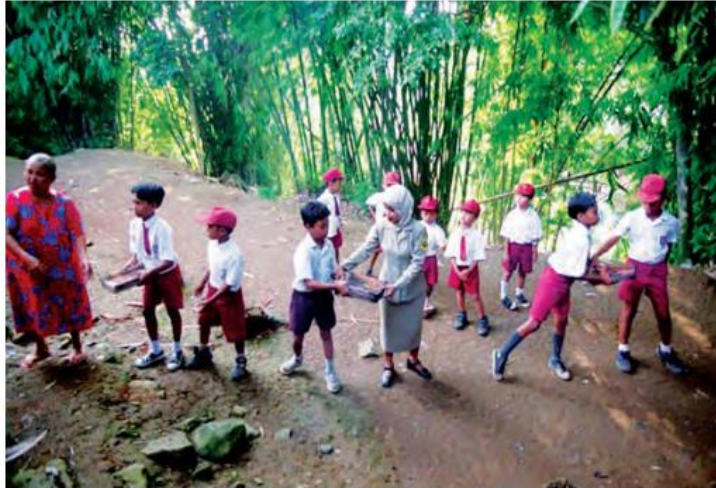
Sumber: www.store.tempo.co/foto/detail/P1106200300315/pembangunan-sdn-bengle-ciampea Gambar 3.8 Murid-murid Sekolah Dasar Negeri (SDN) Bengle Ciampea bergotong royong membangun sekolahnya yang rusak di Ciampea, Bogor, Jawa Barat 27 Mei 2003.
