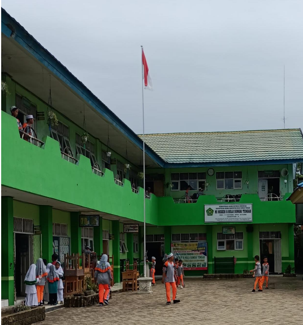
Lokasi MIN 8 Hulu Sungai Tengah
