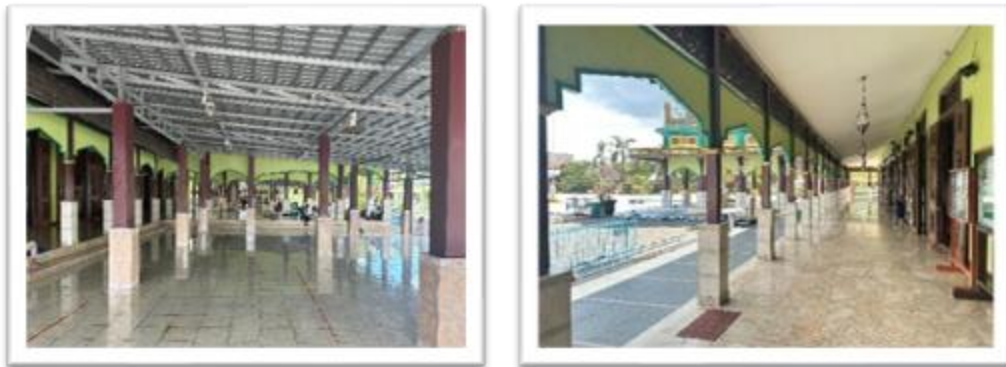
Gambar 4.4 Tiang Keseluruhan Bagian Luar Masjid Jami Banjarmasin
