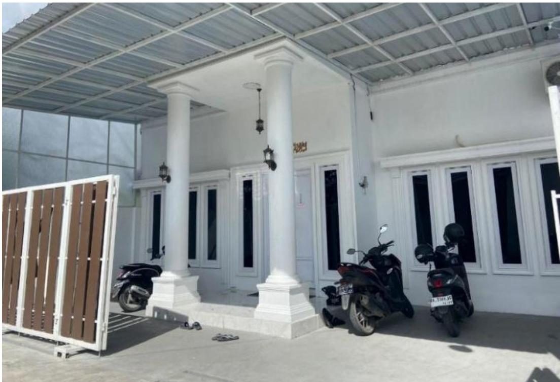
Gambar 4.2 Tampak depan Kantor Pelayanan PT. Turbah Wisata Indah
