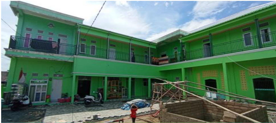
Bangunan PPTQ Tarbiyyatul Aulad dan Kamar Asrama
