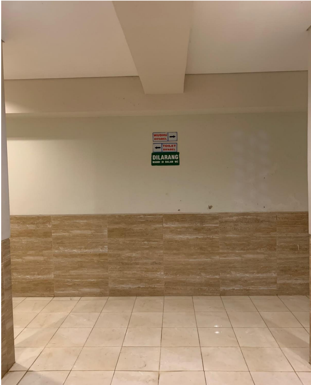
Toilet Khusus Penyandang Disabilitas
