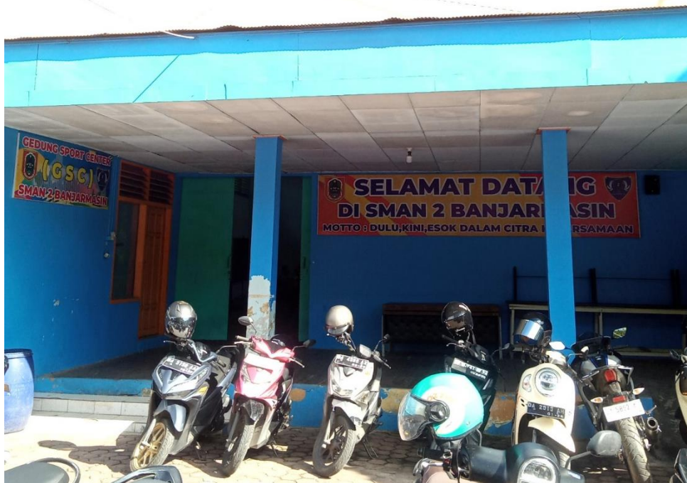
Gedung Serbaguna SMA Negeri 2 Banjarmasin
