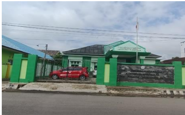
Gambar 4.4 Bangunan KUA Kecamatan Kusan Hilir
