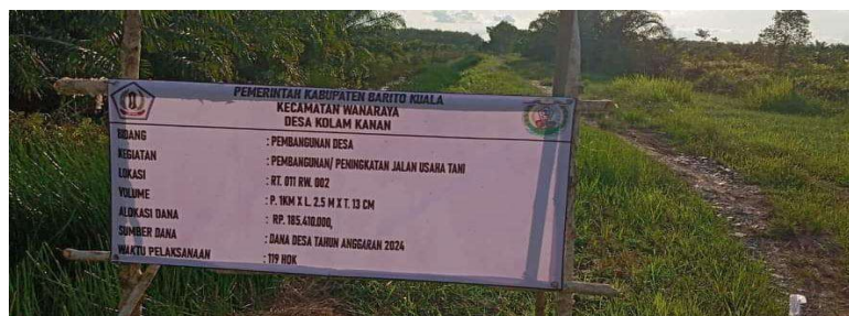
Gambar 1.2 pelaksanaan pembangunan perbaikan jalan desa di desa Kolam kanan
