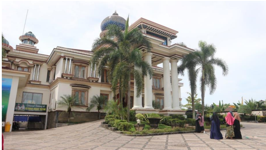
Gambar 4.1 Tampak Depan Bangunan Istana Anak Yatim.
