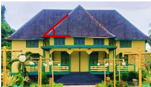
Gambar 4. 40 Sudut lancip pada pinggir atap
