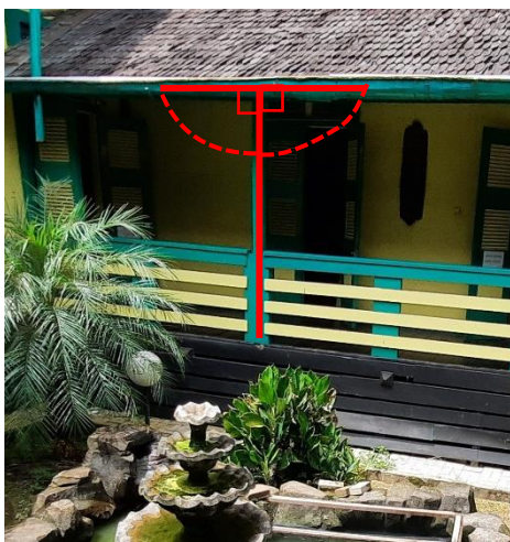
Gambar 4. 43 Sudut Lurus pada Tiang
