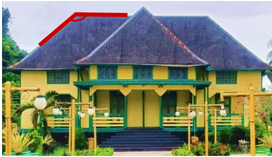
Gambar 4. 42 Sudut tumpul pada pinggir atap
