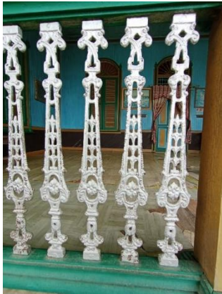
Gambar 4.9 Pagar Pembatas Ruang Tamu dan Teras Rumah Pesanggrahan Kesultanan Bulungan
