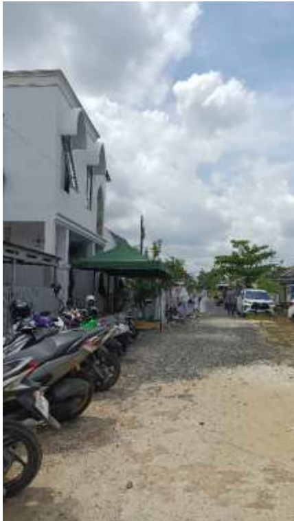
Lampiran 1. Gambar bangunan Majelis Taklim Al Habib Abu Bakar bin Hasan Al Athhos Az-zabidi Banjarbaru
