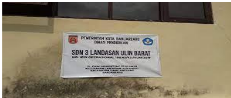
Bangunan SDN 3 Landasan Ulin Utara
