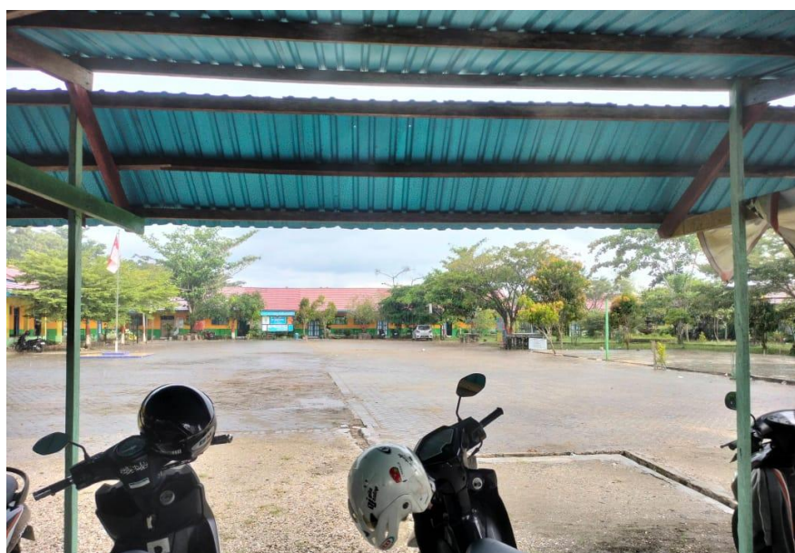
Bangunan SDN 1 Landasan Ulin Utara
