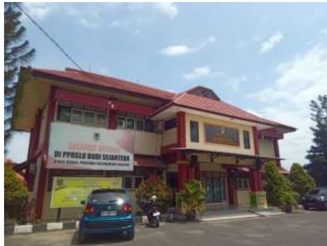
Gambar 4.1 Gedung Kantor Panti Perlindungan dan Rehabilitasi Sosial Lanjut Usia Budi Sejahtera
