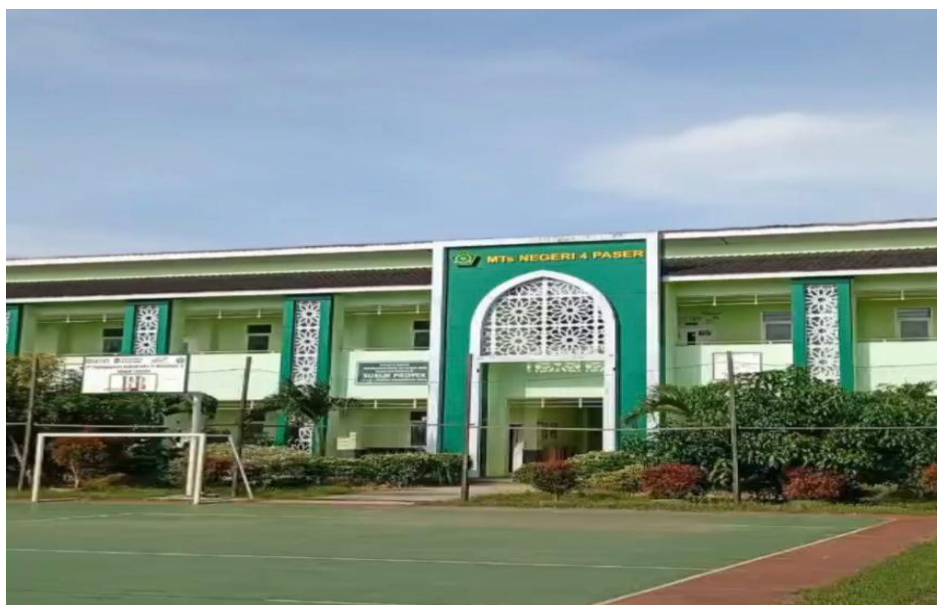
Gedung MTsN 4 Paser
