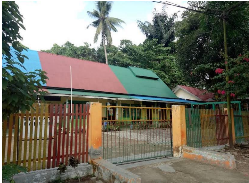
Gambar.4.1 Gedung TK Agrinusa Banjarbaru 54
