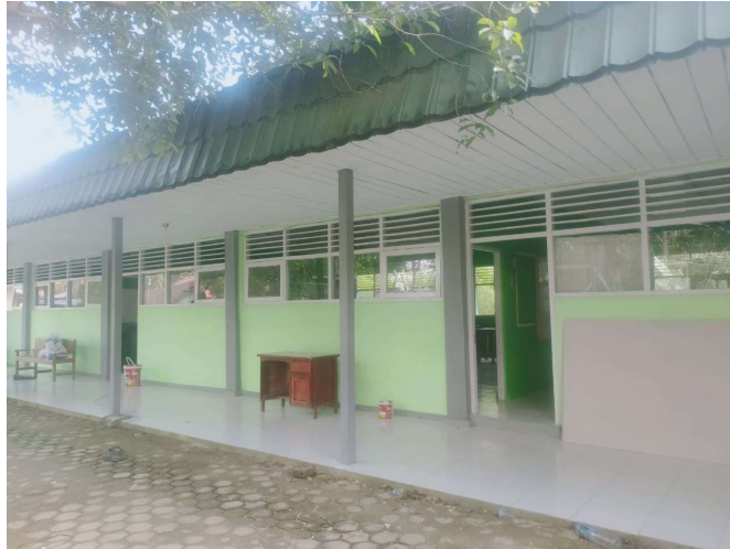
Gambar 4.35 Ruang Kelas PKPPS PPS Sullamut Taufiq
