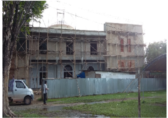
Pembangunan Mushollah Baru PonPes Al-Falah Puteri
