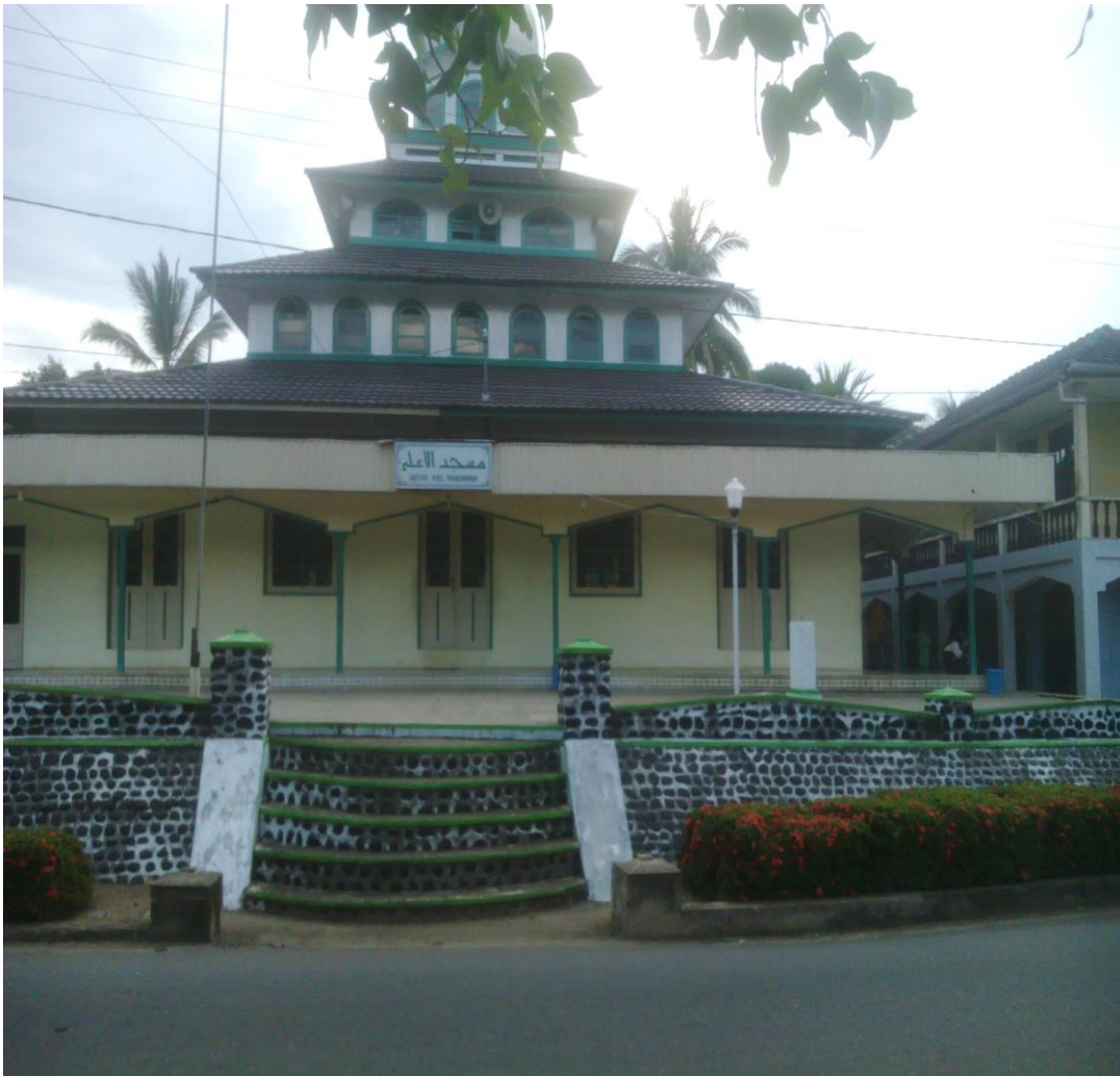
Lokasi Penelitian Masjid Al-A'la Desa Jatuh Kecamatan Pandawan Kabupaten Hulu Sungai Tengah
