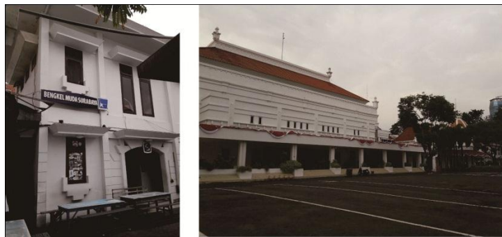
Gedung Dewan Kesenian Surabaya dan Komplek Balai Pemuda Surabaya kini
