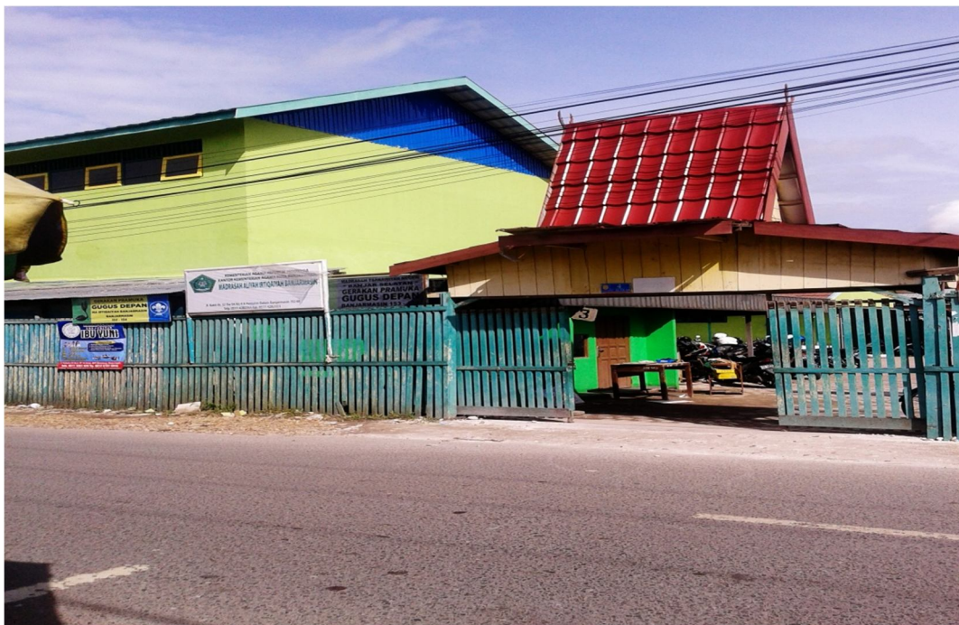
Gambar lokasi MTsN Banjar Selatan lokasi JL.Bhakti.
