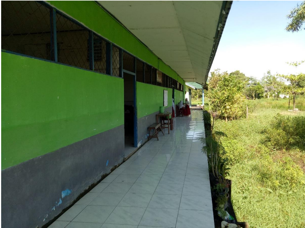
Bangunan ruang kelas SDN Sekata Baru 2
