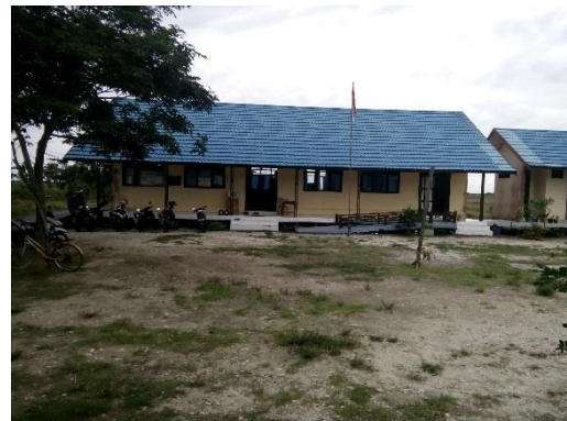
Bangunan kantor dan Lapangan
