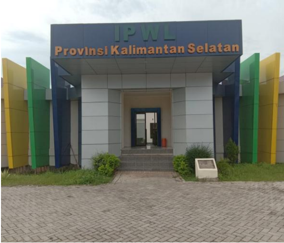
Gedung Rehabilitasi IPWL Intan Banua
