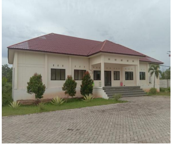
Gedung Kantor Utama
