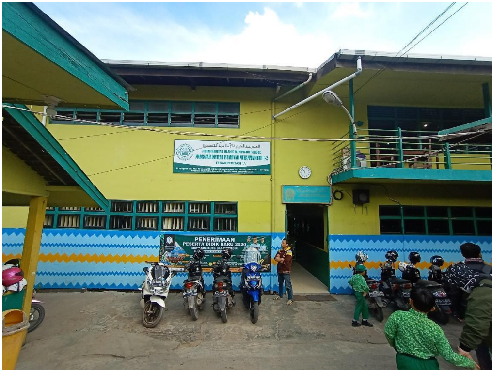
Foto keadaan sekolah bagian tampak depan.
