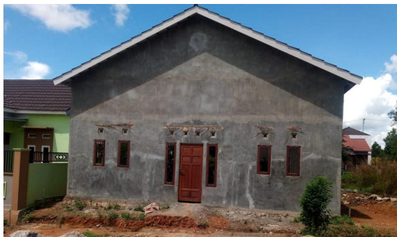
GAMBAR 4.3 Progres Pembangunan Rumah Shelter Mualaf
