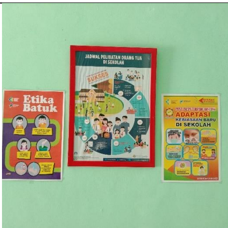
Cdf.10.12. Kondisi dinding di PAUD Islam Terpadu Bintang Kecamatan Kertak Hanyar.
