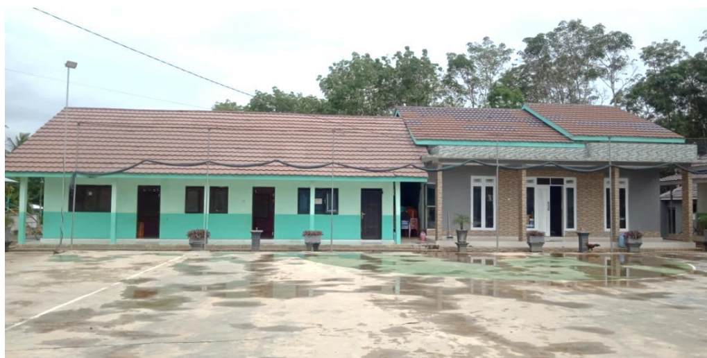
Gambar: Ruang kelas A dan B, ruang UKS dan ruang guru.
