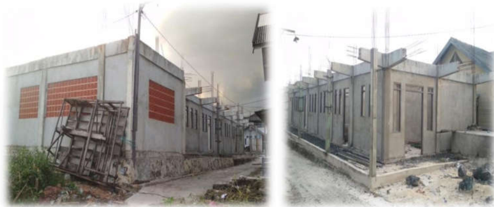
Foto pembangunan Gedung ke 4, Asrama Tahfiz Putra
