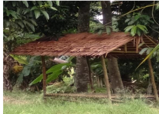
Gambar XIII. Atap yang Terpasang
