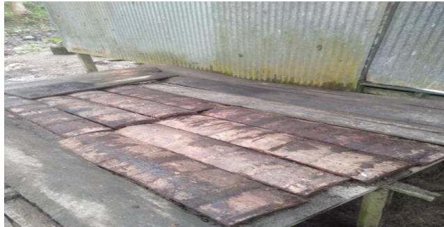
Gambar XXVI. Lantai dari Kulit Batang Rumbia (Sumber: Dok. Pribadi, 2021)
