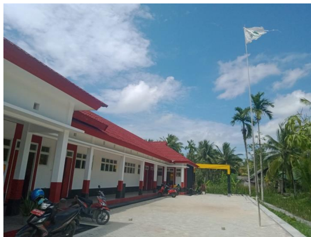
Gambar 8. Bangunan SDN Pulau Satu
