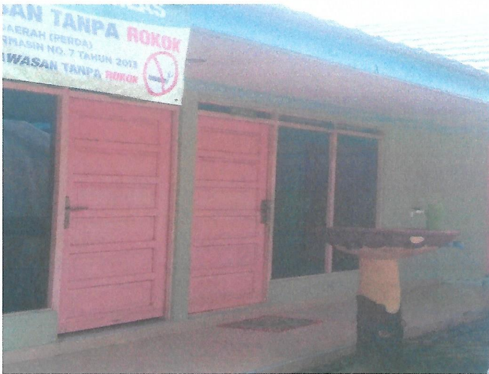
❖ Tampak depan ruang Aula Panti Asuhan Al-Ikhlas Banjarmasin
