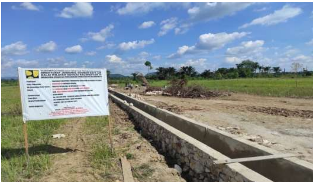
Gambar 6 Awal pembangunan Saluran Irigasi
