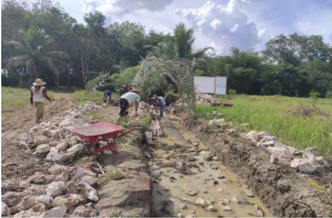
Gambar 7 Proses Pembangunan Saluran Irigasi
